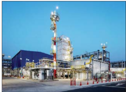
SK E&S 인천 액화수소플랜트 전경 /SK이노베이션 E&S
