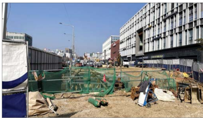
공사 중인 둔촌주공역 2번 출구.
