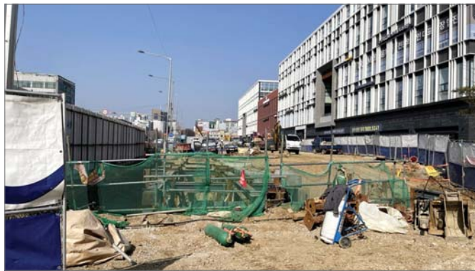
공사 중인 둔촌주공역 2번 출구.
