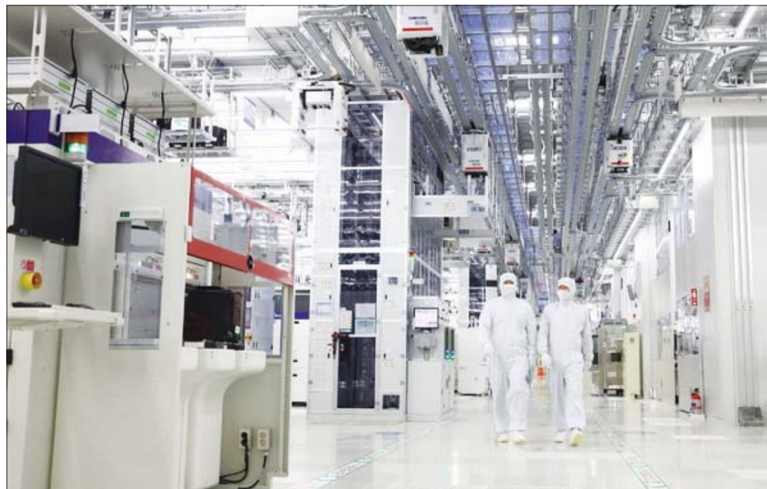
삼성전자 평택 캠퍼스 반도체 공장 내부.
