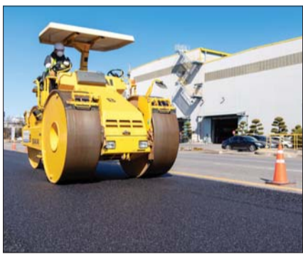
광양제철소가 제강슬래그를 골재로 활용한 아스팔트 콘크리트로 제철소 내 도로를 포장하고 있다.
