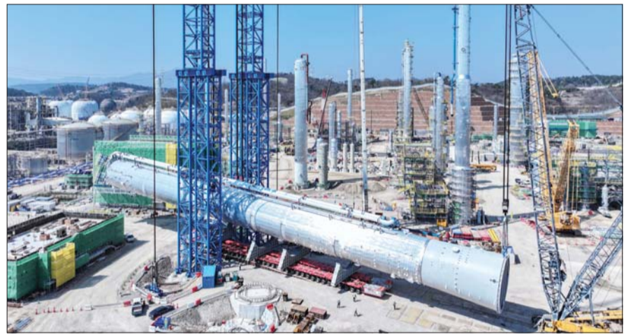
에쓰오일은 최근 국내 최대 규모의 프로필렌 분리타워 설치를 성공적으로 완료했다고 30일 밝혔다. 이 프로필렌 분리 타워는 높이 118m, 직경 8.5m, 무게 2370톤에 달해 국내 석유화학 설비로는 사상 최대 높이를 자랑한다.
