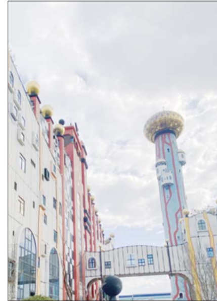
일본 오사카 시내의 인공섬 ‘마이시마 소각장’ /수도권매립지관리공사
