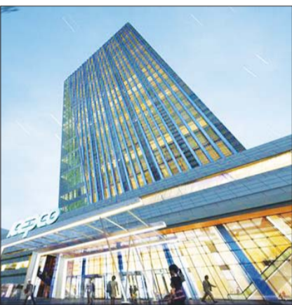
전라남도 나주에 위치한 한국전력공사 신사옥. /뉴시스
