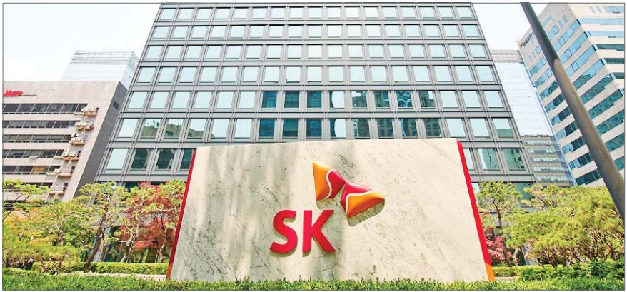
SK 사옥 전경. /SK
